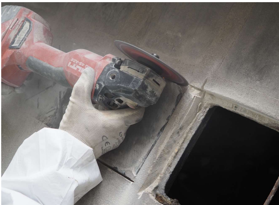
Zkouška vyjmutí luxferů, provedená v září 2025.
