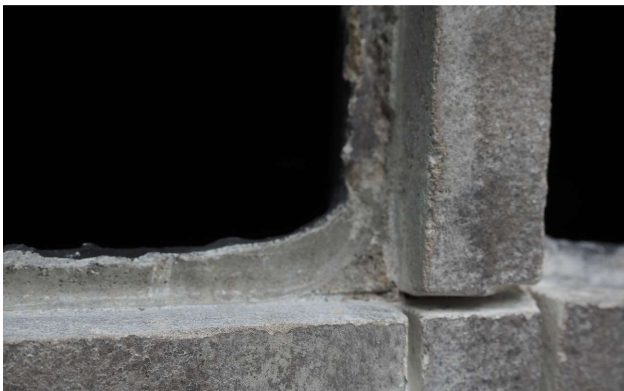
Jasně patrné stopy po vtlačení luxferu do ještě mokré hmoty tmelu (nerovné okraje, bublinky pod sklem, hladká plocha ve stuku s luxferou apod.)
