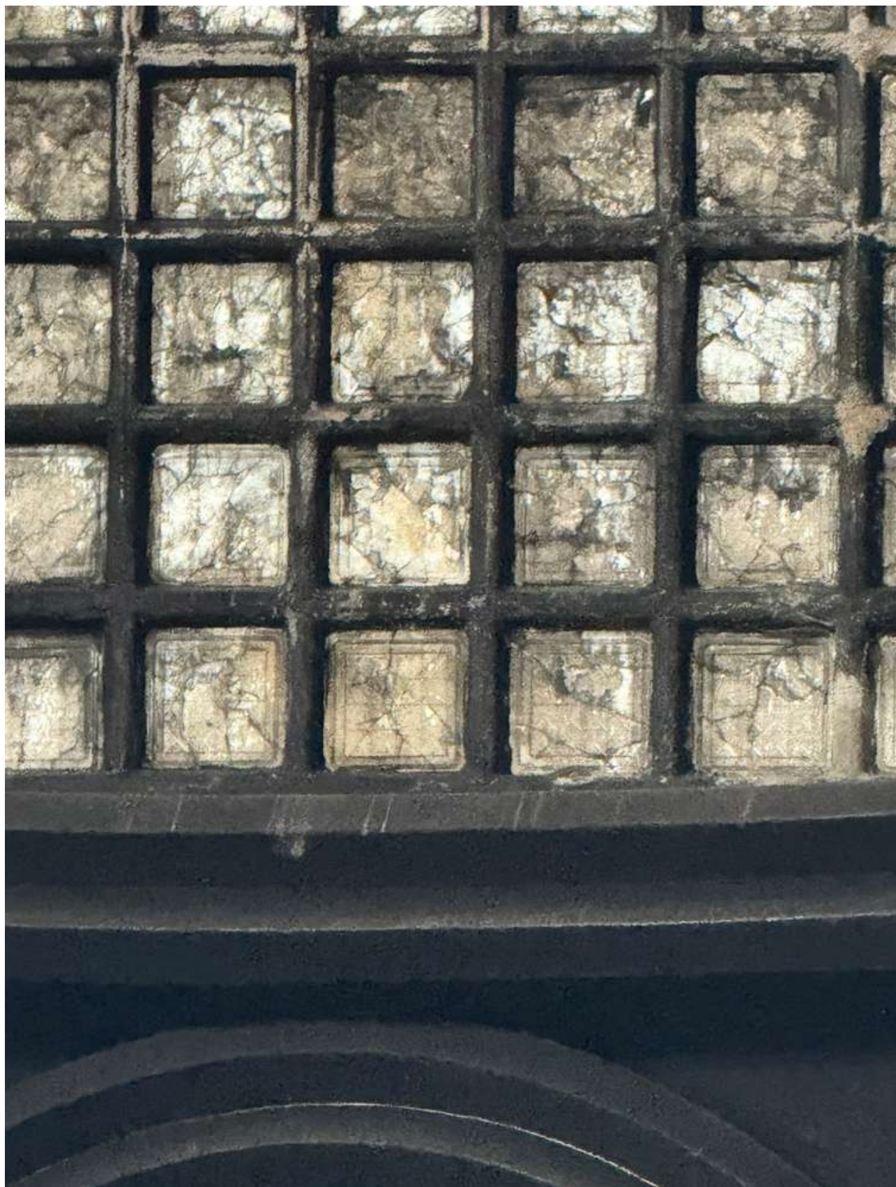
Dekoratívní spáry mezi jednotlivými luxferami se silně zkorodovaným povrchem (světlé plochy sprášujícího se materiálu). Na hraně římsy stopy po zatékání.
