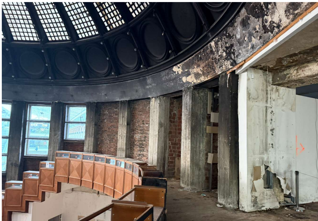
Spodní hrana kupole kde došlo k požáru, narušený povrch omítek je jasně patrný vpravo.
