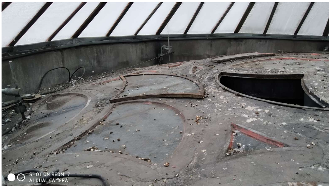
Stav vrcholové růžice na rubu klenby. Jasně patrné jsou ocelové rámy do nichž jsou osazeny skleněné výplně, napravo jedno z otevíracích výplní (je zcela vyjmuta), v levé části část mechanismu pro otevírání segmentů
