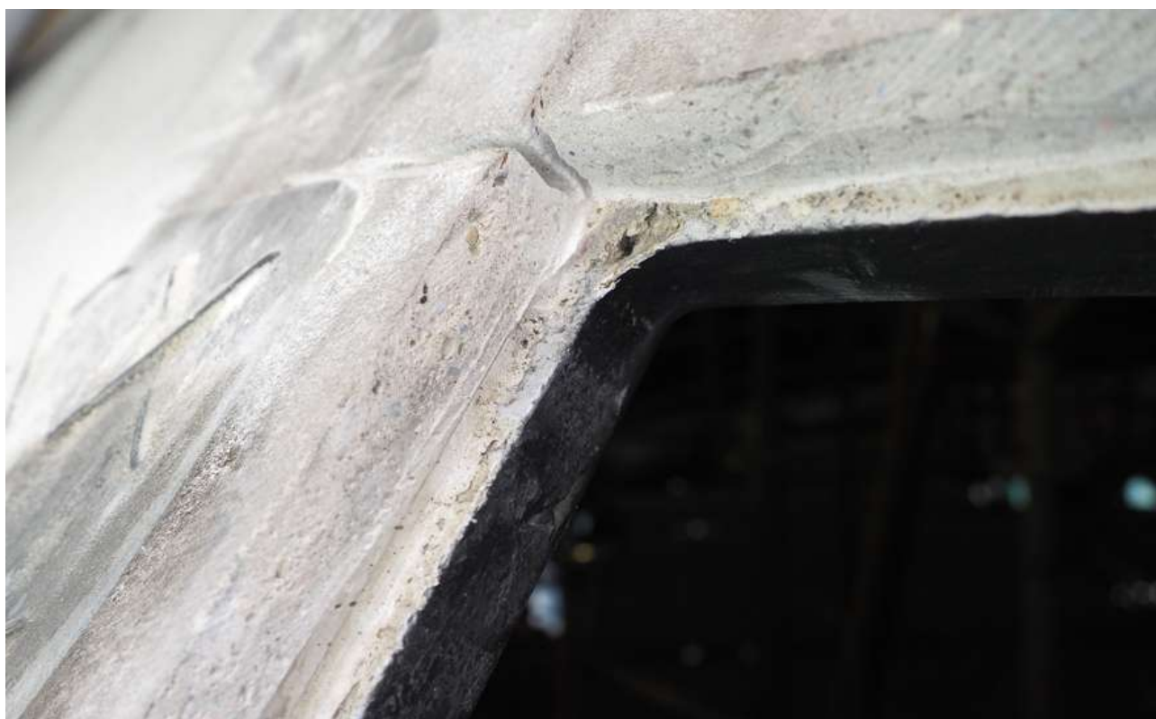
Tmel byl vytvořen z velmi jemného kameniva a cementového pojiva.
