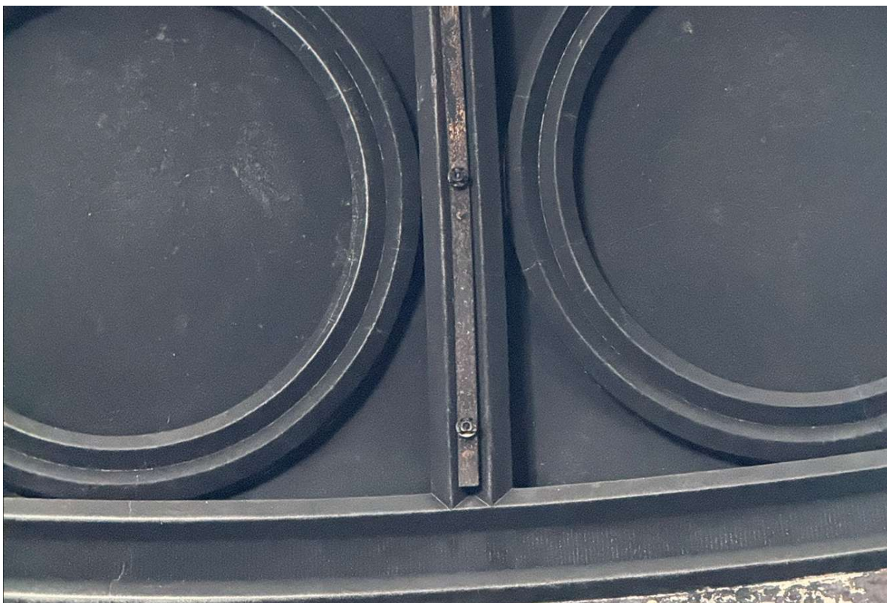
Zčernalý povrch teracových omítek. Uprostřed elektroinstalace světel na dřevěných lištách, upevněných do betonu šrouby.
