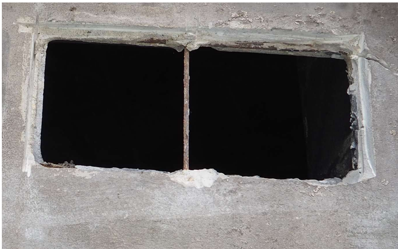
Ocelové výztužné tyčinky vkládané do tmelu při vkládání luxferů. Patrná je celoplošná koroze prvků.
