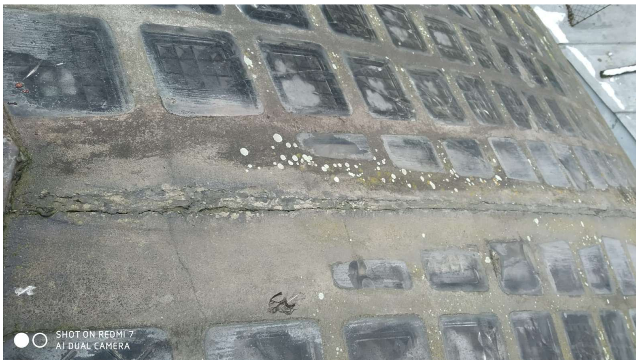
Stav rubové strany kupole. Trhlina v místě napojení na železobetonové žebro klenby.
